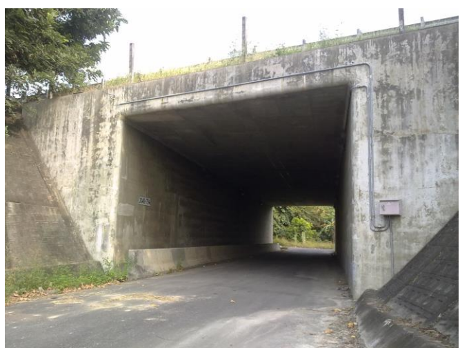
照片 4. 大型涵洞
