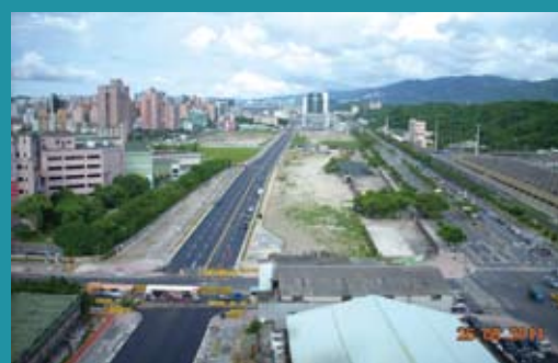
向陽路-南港站間平面道路工程施作
