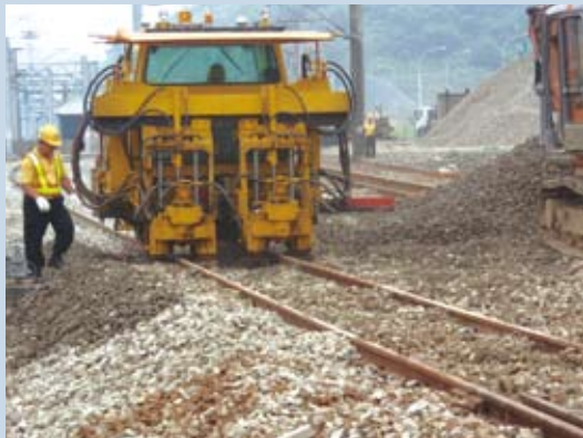
鋪軌道礮道施工
