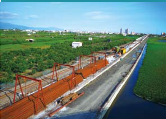
南二高橋下至林邊溪北端引道段鋪軌施工
