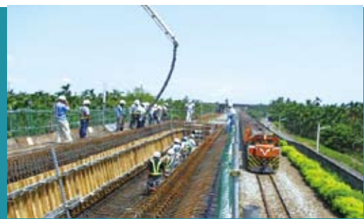
竹田段箱型梁施工
