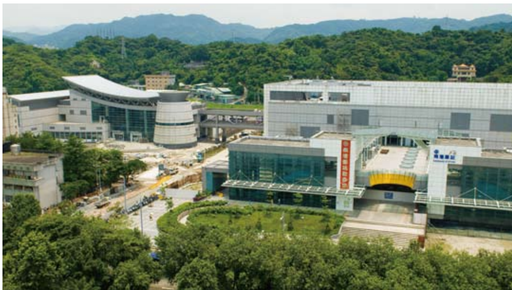
南港車站北側及高鐵出入口全景
