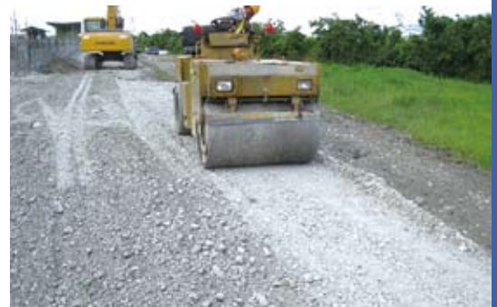
壽豐車站高架臨時軌路基回滾壓施工
