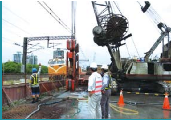
連續壁TYPEST1S03挖掘
