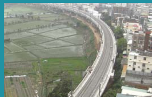
竹科（新莊）站至竹中站段完成現況
