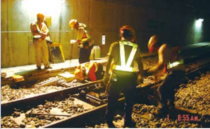
號誌電動轉轍器附件間隙調整
