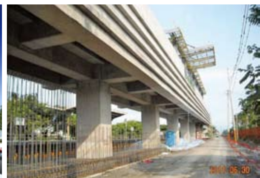
麟洛高架車站施工
