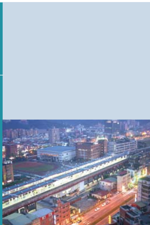
南港車站臺、高鐵北側出入口廣場全景鳥瞰
