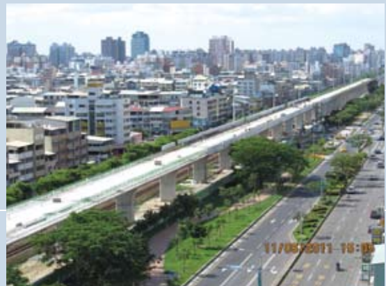
太原至精武高架段上構箱型樑施工
