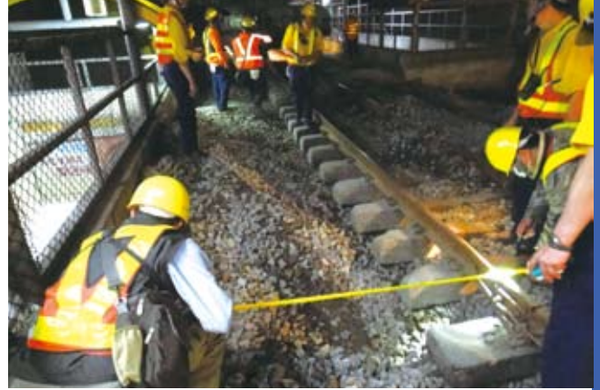
測量隊測量支距離確定軌道已就定位
