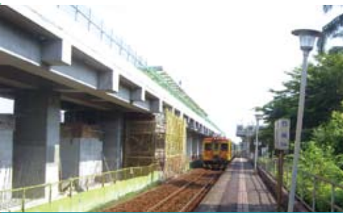
竹田高架車站施工
