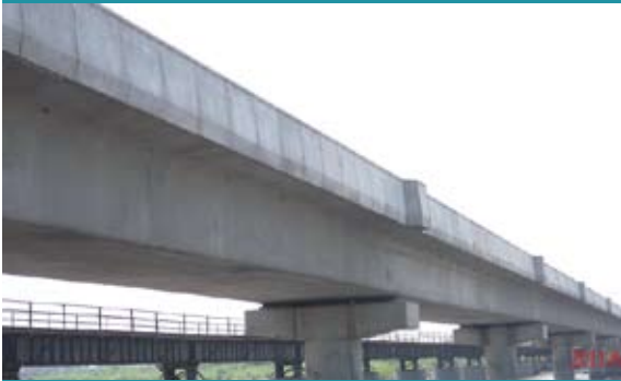
林邊溪橋結構完成情形（左側為臺鐵現有林邊溪橋）
