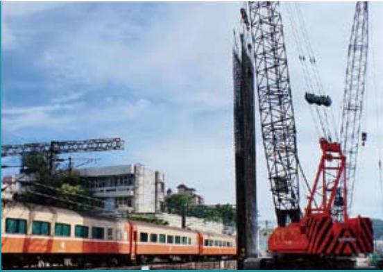
中華三路段北側連續壁施工作業
