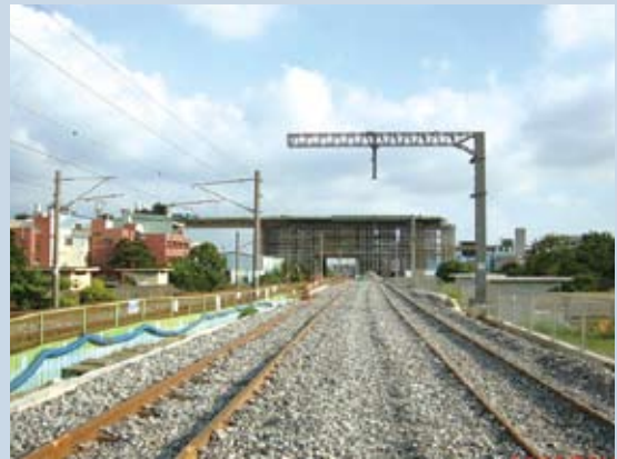
潭子段臨時軌道工程
