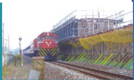
竹田段箱型梁施工
