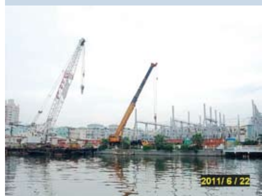
舊愛河橋墩柱遷離作業
