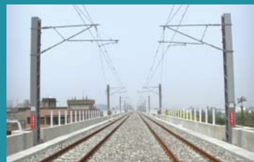
內灣高架工程軌道鋪設及電車線完成
