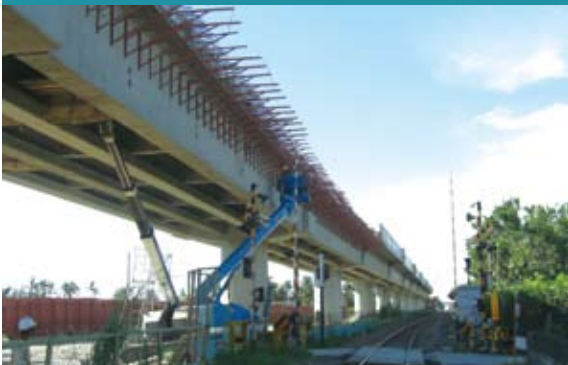
林邊溪北岸至埕子第一排水間橋面翼版三角支撐架施作工程
