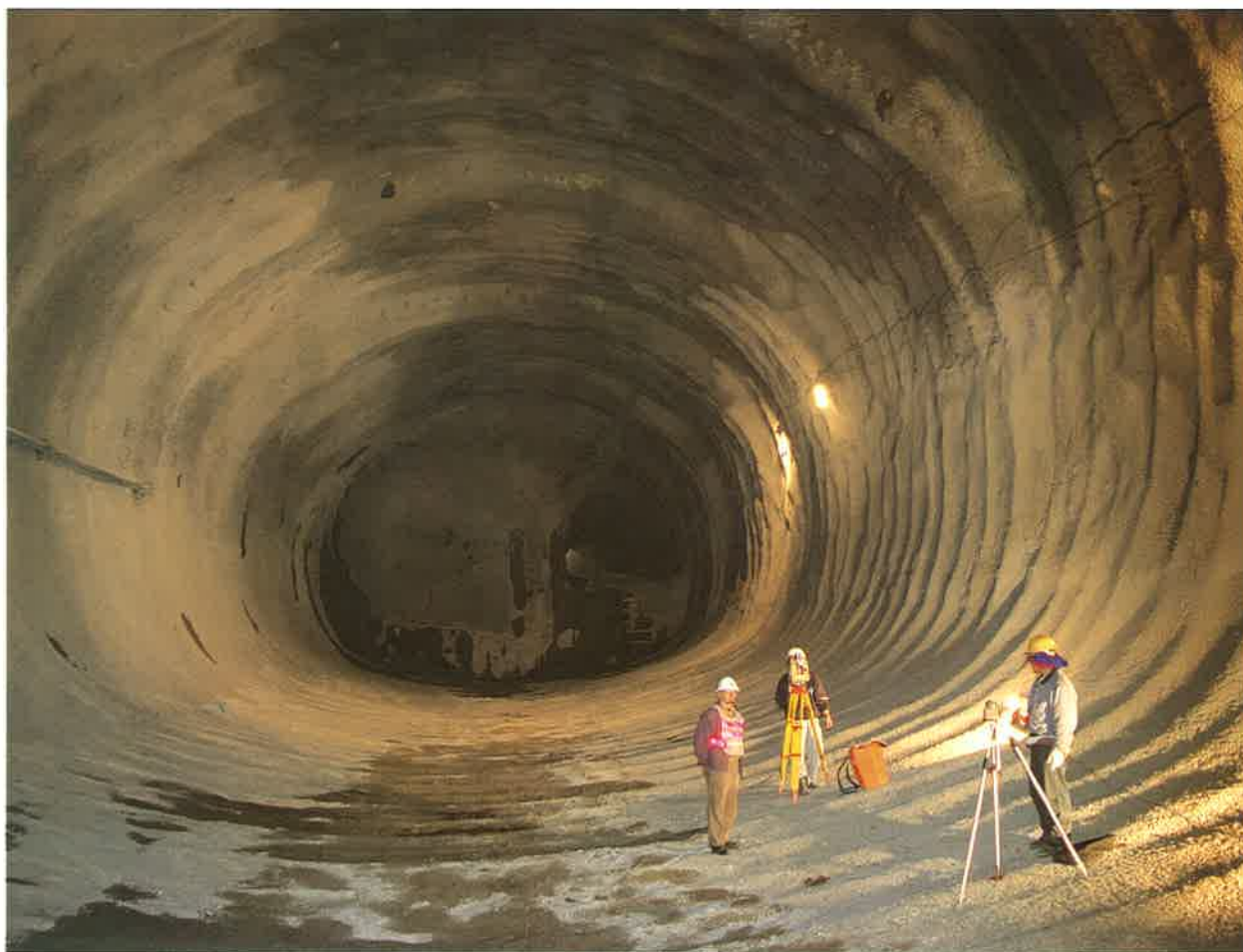
蘭潭隧道工程
