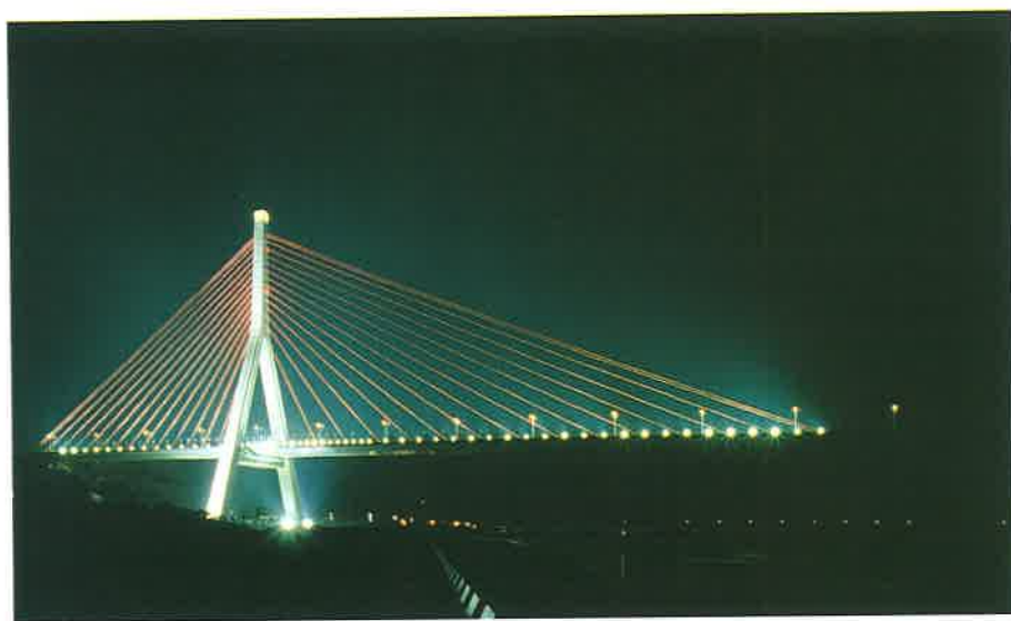
高屏溪斜張橋景觀照明
