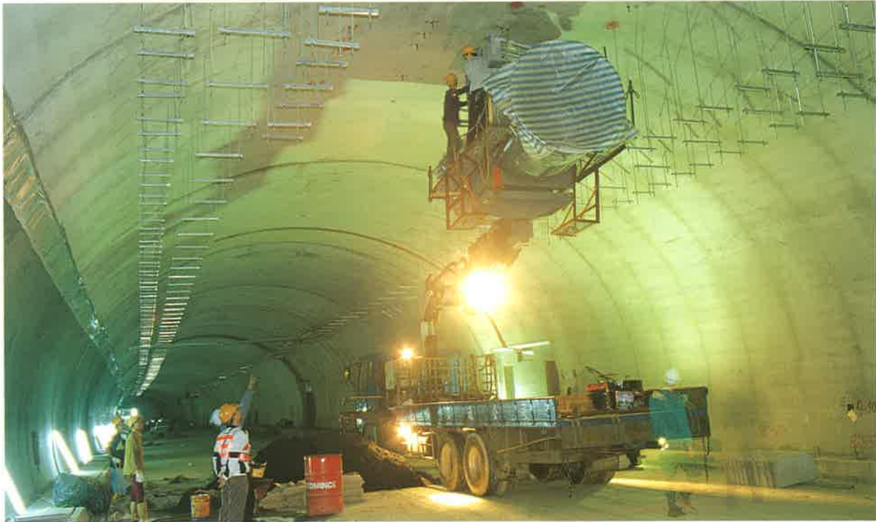
基隆隧道機電工程
