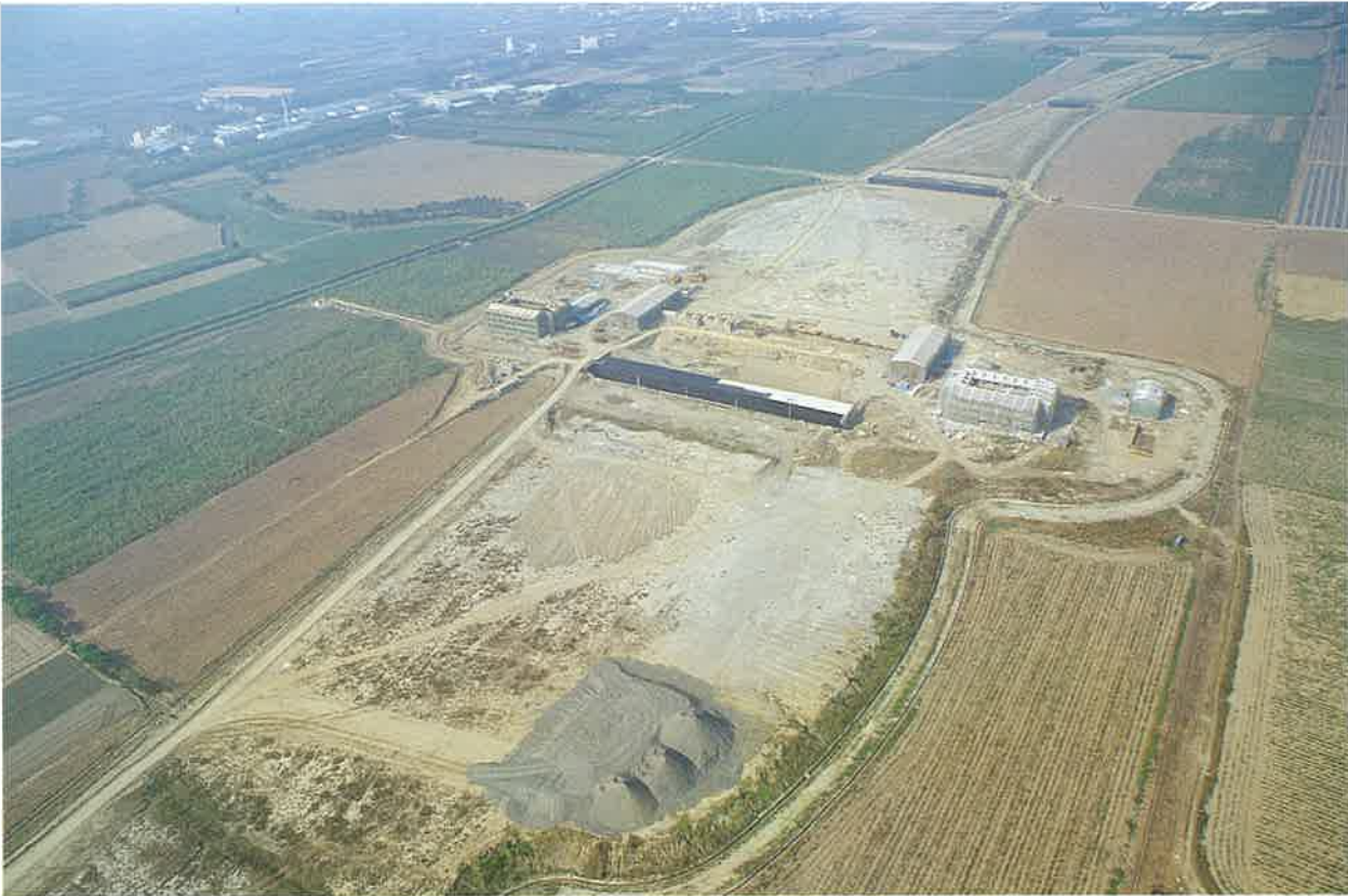
善化收費站工程
