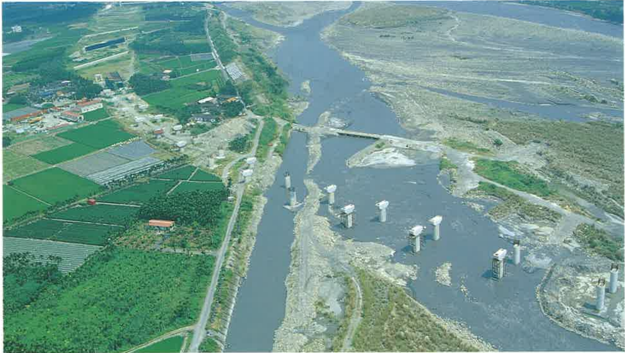
濁水溪河川橋工程
