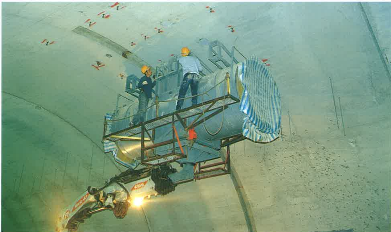
基隆汐止段基隆隧道通風機安裝
