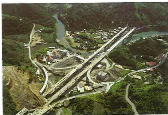
坪林行控中心專用道工程
