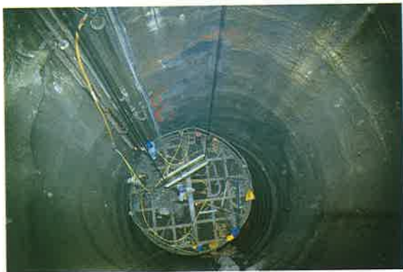
坪林隧道二號豎井工程
