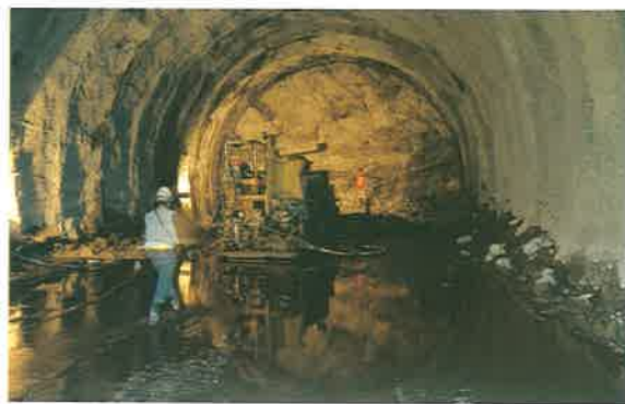
坪林隧道主坑西洞口工程
