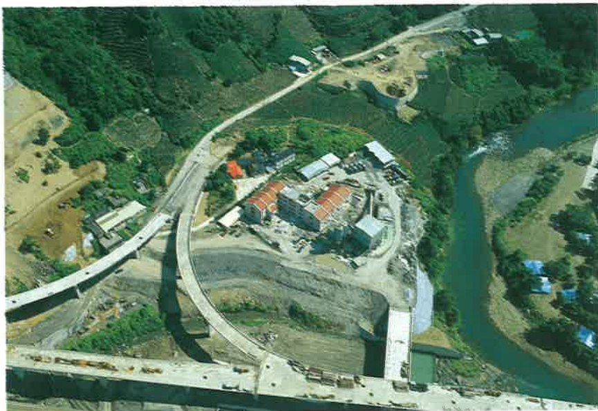
北宜高速公路坪林行控中心工程 完成。
