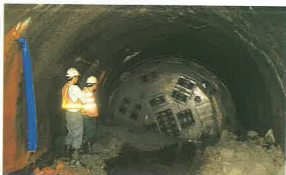
導坑TBM恢復推進作業
