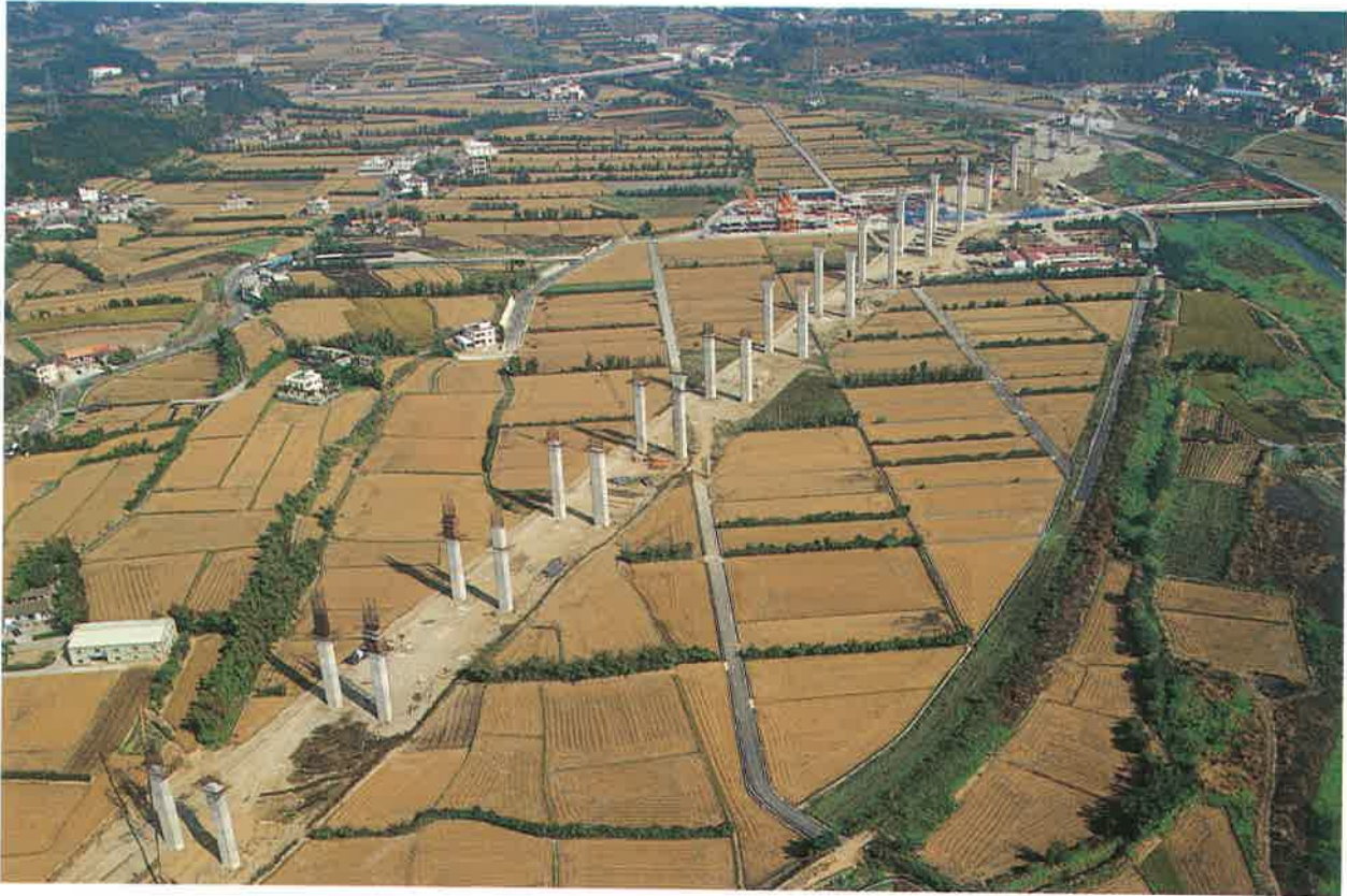
西湖西橋工程
