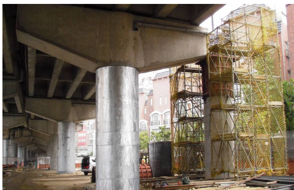
桃園高架橋鋼板包覆
