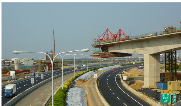
施工中交通維持設施
