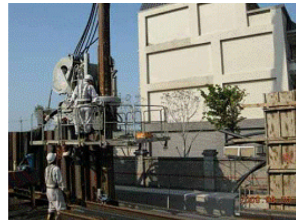
低噪音、低震動擋土植樁工法
