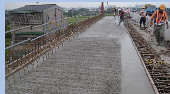
橋梁基礎耐震補強工程一橋面板澆置，混凝土施工均勻度高，降低拆模之表面修飾作業人力。
