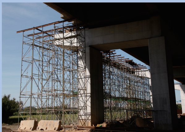
大浦高架橋下部結構 RC 包覆耐震補強後，進行上部結構拓寬作業。
