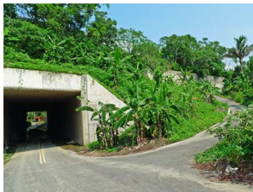
圖 7.3-3 穿越橋下方和外側有平面道路通過(98年9月拍攝)
