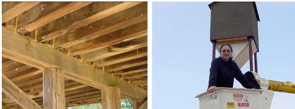
圖 9.5.1-3 利用發泡劑填滿隙縫(左)與新建的蝙蝠巢箱(右)
