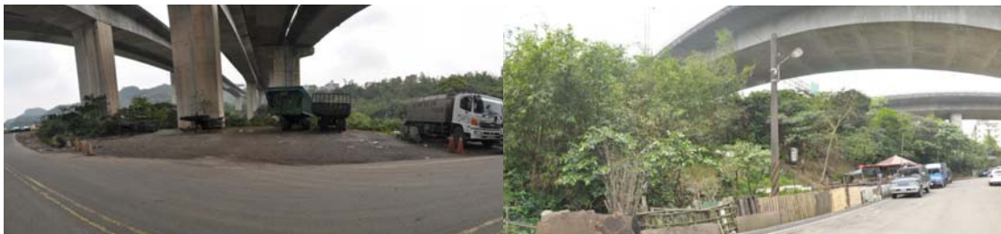
圖 9.4.2-2 國道 3 號第 1 號高架橋橋下空間(0k+001-0k+690)
