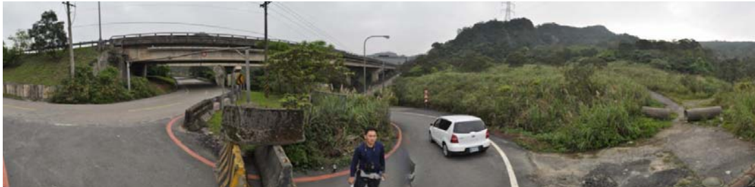
圖 9.4.3-3 第 6 號高架橋 5k+265-5k+385 可改善與 2 次植生的橋下空間
