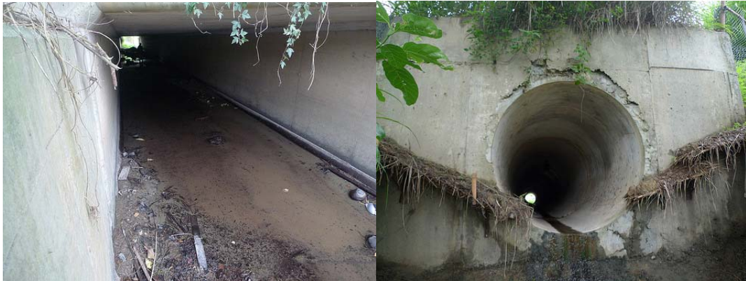
圖 9.4.2-6 路堤段作為生態廊道的箱管涵
