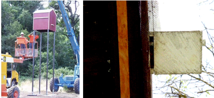
圖 9.5.1-2 蝙蝠巢箱提供臨時棲所(左)與網目阻止蝙蝠使用橋梁隙縫(右)
