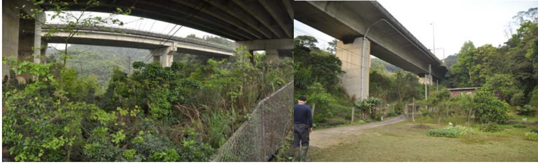
圖 9.4.2-5 國道 3 號第 6 號高架橋(左)與第 9 號高架橋下空間
