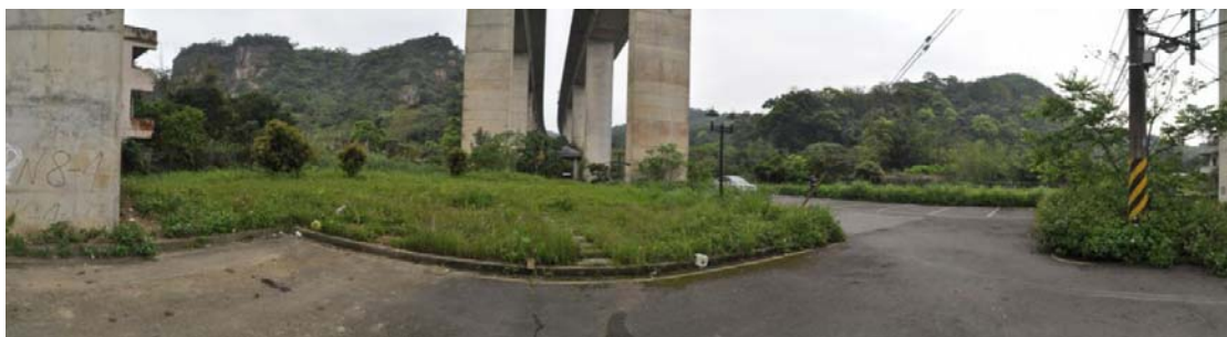
圖 9.4.3-2 橋下空間成為公園用地而失去生態廊道功用
