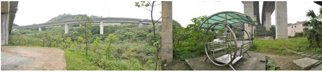
圖 9.4.2-3 國道 3 號第 2 號高架橋與第八號高架的橋下空間成為公園
