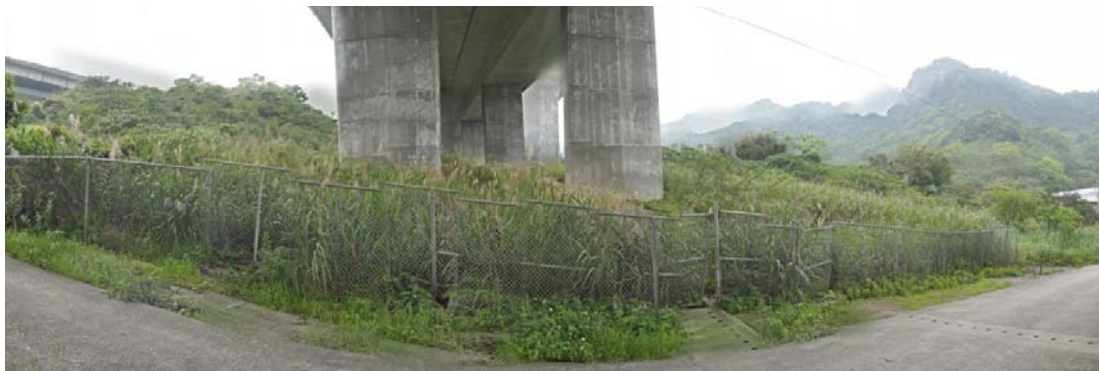
圖 9.4.2-4 國道 3 號第 3 號高架橋(3k+113-3k+428)可 2 次植生加速演替
