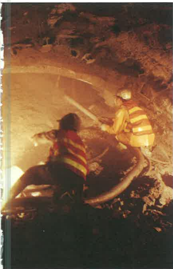
◎坪林隧道導坑工程噴漿作業
