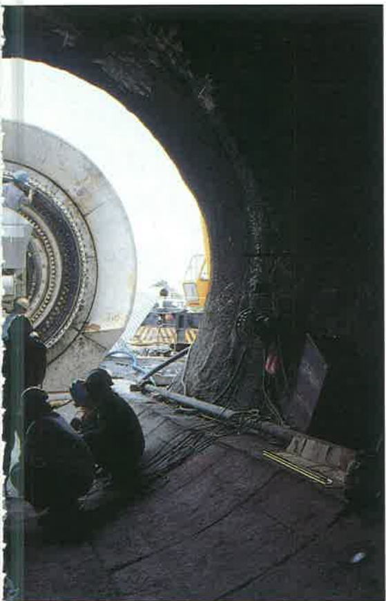
◎ TBM 進洞前準備
