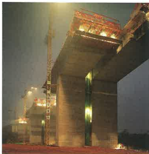
◎牛欄河二號橋
