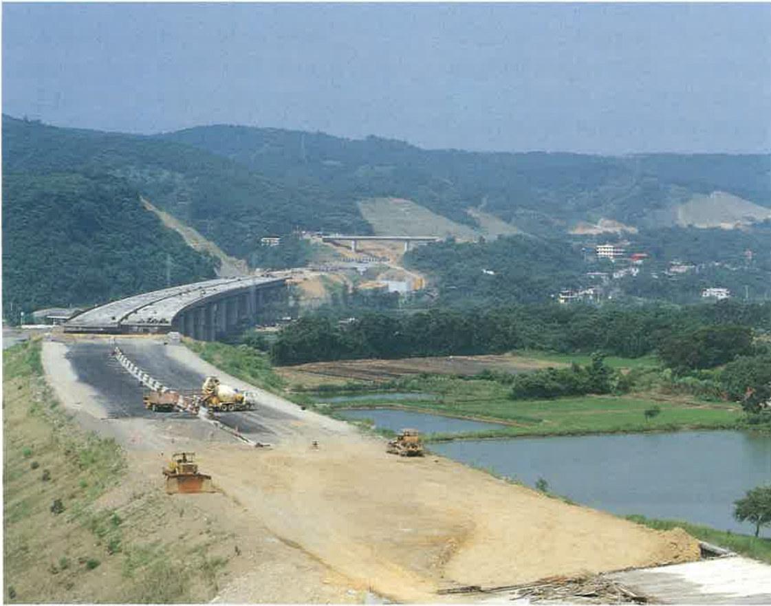
◎關西至坪林段路工
