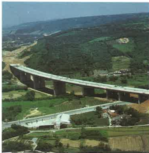
◎牛欄河二號橋
