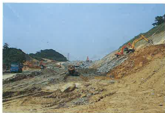
◎中和至土城段路工
